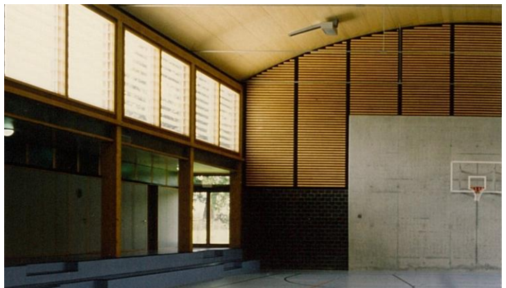
Vue de la halle à l'intérieur
