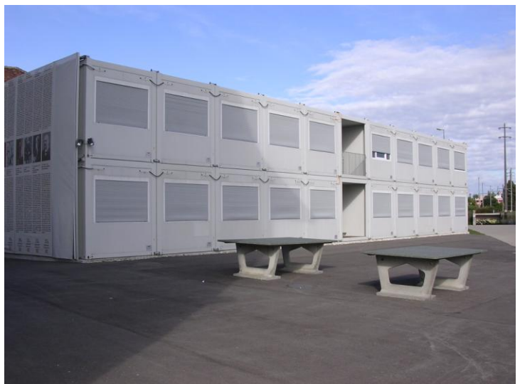
Vue depuis le sud
