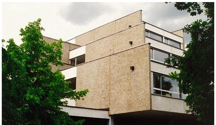
Vue détail façade
