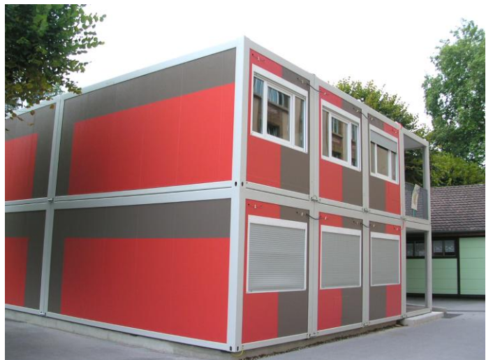
Vue depuis le sud
