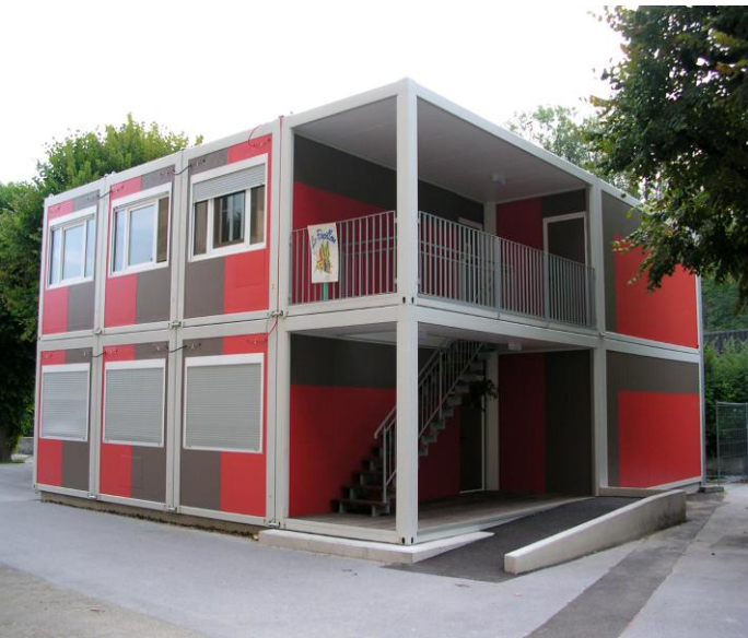
Vue depuis l'ouest
